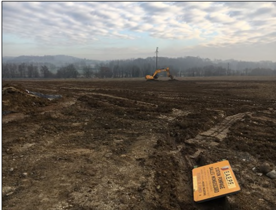
Figure 9 : Site après remise en état
