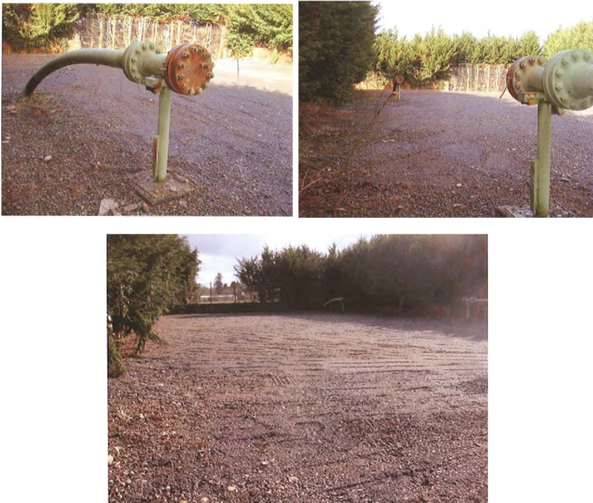
Figure 3 : Vues du site de l'ancienne station de pompage de Salles-Mongiscard après démantèlement
