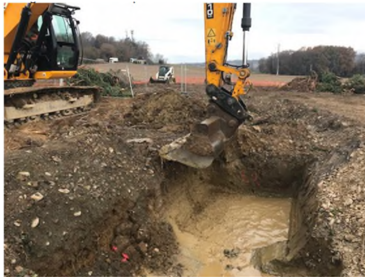
Figure 5 : Fond de fouille
