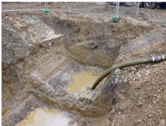
Figure 6 : Vues sur le pompage des eaux en fond de fouille
