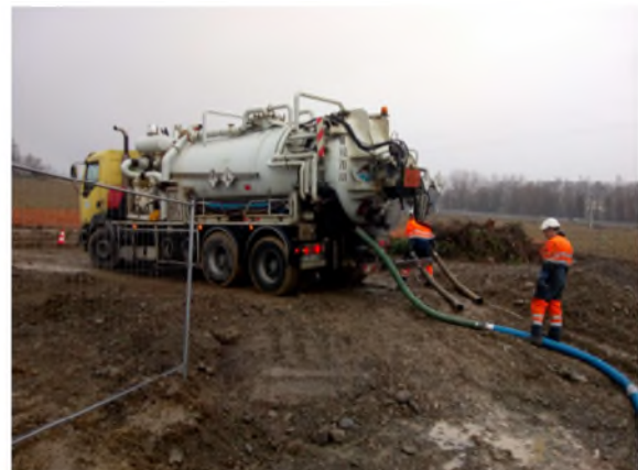
Figure 6 : Vues sur le pompage des eaux en fond de fouille
