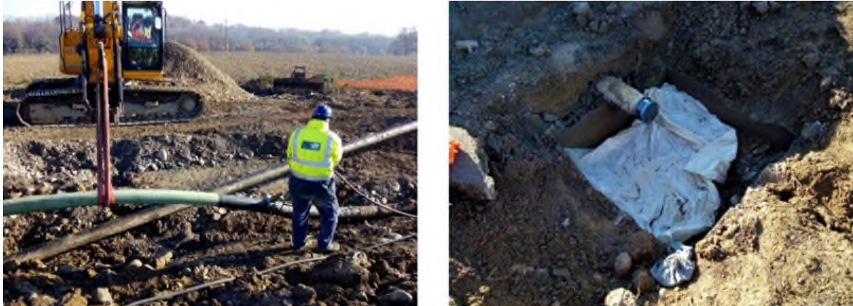
Figure 8 : Découpe et obturation des canalisations
